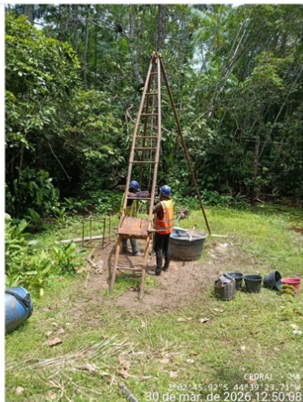
EXECUÇÃO DE SONAGEM
