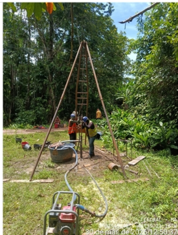
EXECUÇÃO DE SONAGEM
