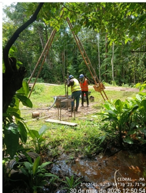
EXECUÇÃO DE SONAGEM
