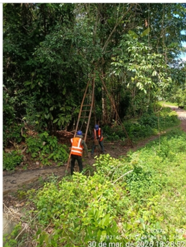
EXECUÇÃO DE SONAGEM
