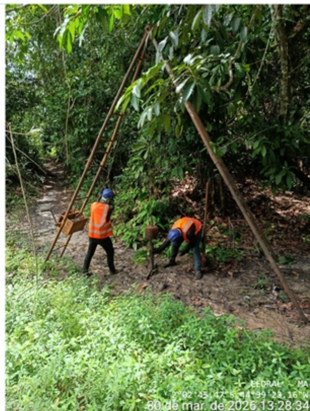
EXECUÇÃO DE SONAGEM
