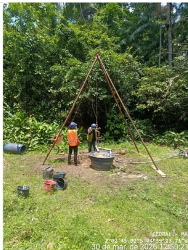
EXECUÇÃO DE SONAGEM
